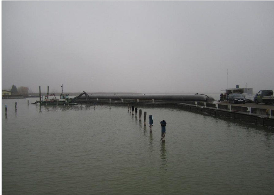
Pogled na radilište
