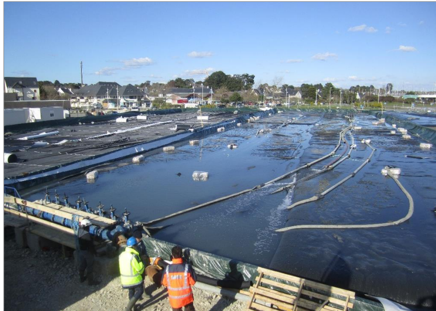
Zona odmuljavanja s 3 ćelije (ćelija 2 u radu)
