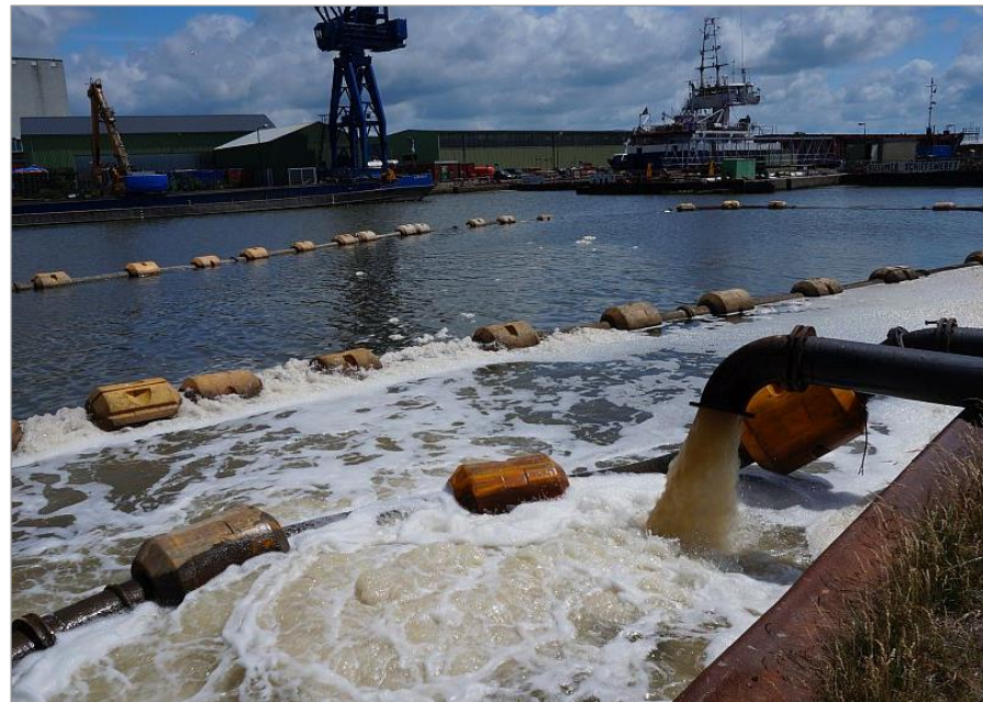
Ponovno napajanje lučkog bazena filtratom
